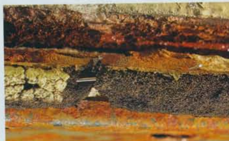
Für museale Zwecke völlig ausreichend: Diese Türdichtung wurde mit einer Stecknadel fixiert und bleibt als Materialprobe erhalten
