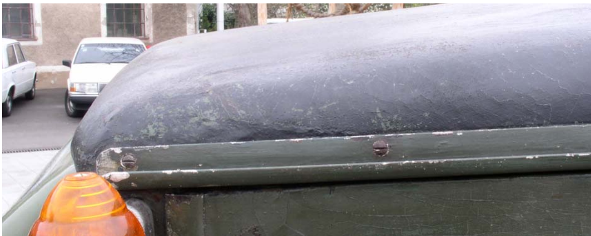
Foto 6: Dach vorn links; Endzustand
